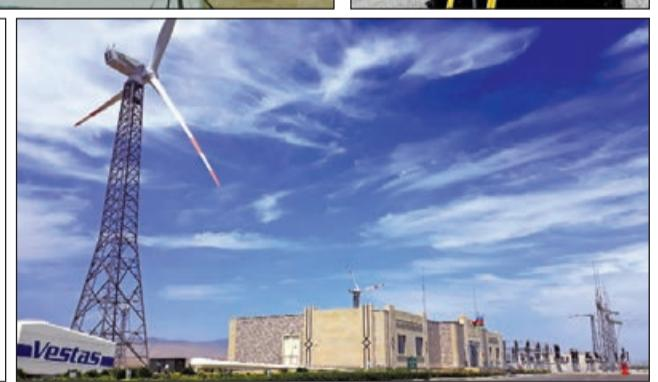
Baki şəhərinin elektrik təchizatının yaxşılaşdırılması, elektrik enerjisinin artan təlabatın ödənilmesi üçün Xəzər rayonunda 1 yeni inşa edilmiş 10/35/10 kV-luq 2x40 MVA gücündə "Buzovna-1", Yasamal rayonunda 110/35/10 kV-luq 2x50 MVA gücündə "Bayramzadə" yarımstansiyalarında təamlamlı, Pirallahi rayonunda Hövşən zeytin zavodunun transformator məntəqələri inşa edilərək və yeniden qurularaq istismara verilmişdir.
