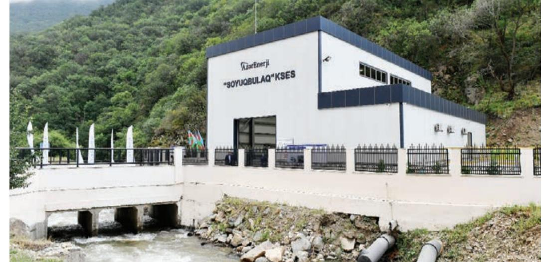
elektrik stansiyasının baş suqəbuləcidi qurğusunu, 6 kilometr uzunluğunda derivasiya boru xətti, maşın zalı yenidən qurulub. Stansiyada Avropa istehsalı olan yaşıł sertifikasi, iki müasir ekoturbin, generatorlar, idarəetmə və avtomatika panelləri quraşdırılıb. Stansiyada enerjisistemo integrasiyası üçün uzunluğu 6 kilometr olan 6 kV-luq kabel xətti çəkilib və eyni zamanda optik kabel xətti ilə də əlaqələndirilib. Ərazidə fors-major hallar üçün ehtiyat dizel generatoru da qurasdırılıb.
