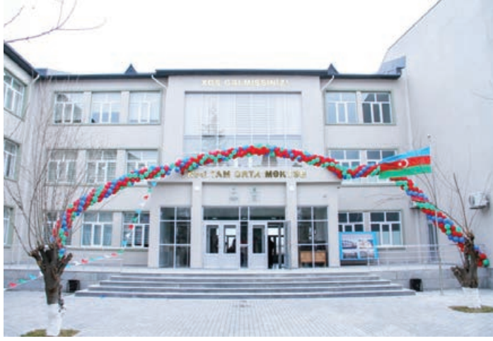
1937-ci ildə inşa edilən məktəbdə uzun illər heç bir təmir işi aparılmadığından qəzalı vəziyyətə düşmüşdür.
