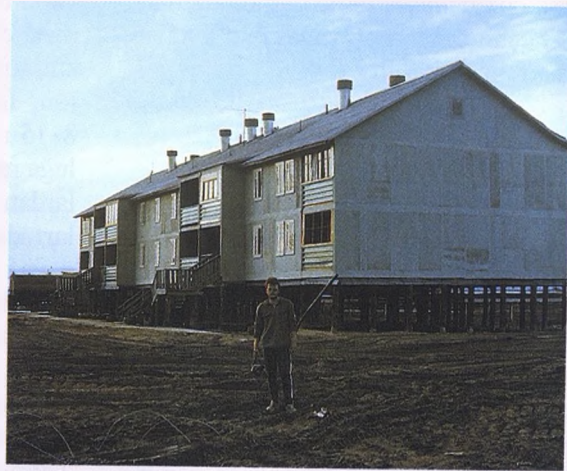
Daimi donuşluq rayonunda dayaqlar üzərində tikilmiş ev.
