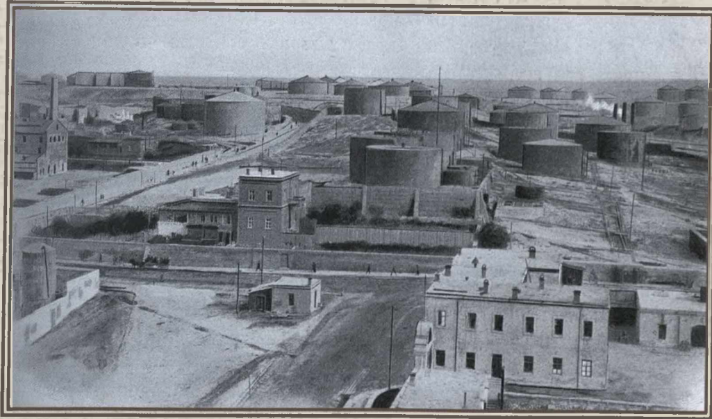
"Nobel Qardaşları" şirkətinin zavodlarında neft rezervuarları. 1895-ci il
