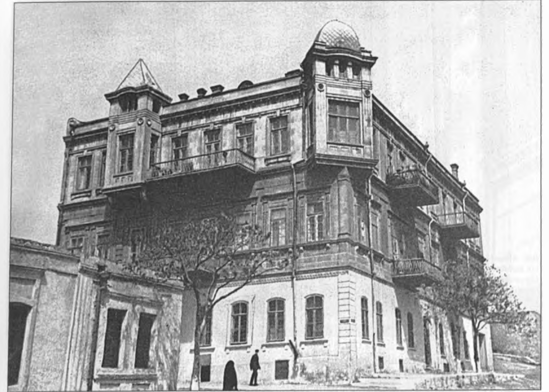
Bakı. Figarov qardaşlarının yaşayış evi. Abşeronskaya küç. 7. Ümumi görünüş. 1912-ci il. Mülki mühəndis N.Q.Bayev.
