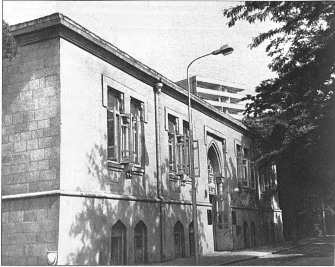
Baku. Sadat məktəbinin binası. Fasadın mərkəzi hissəsindən fraqmentlər. Mülki mühəndis Z.b.Əh-mədboyov. 1912-1913-cü illər.
