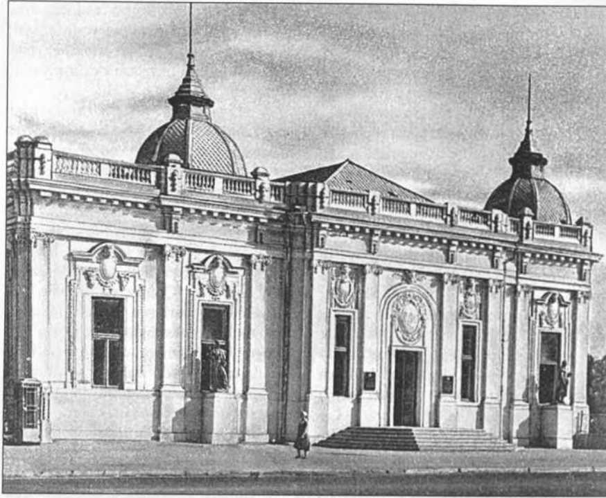
Bakı. Bulvarda "Fenomen" sinematoqraf binasının (indiki Kukla Teatrı) ümumi görünüşü. Mülki mühəndis İ.K.Ploşko.
