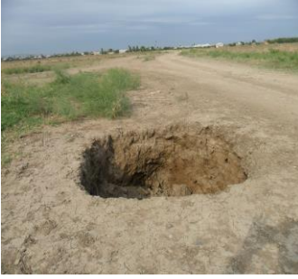
Şəkil 5. Axçabəy çayının yaxınlığında kəhriz quyusu üzərində açılan dəliklər
