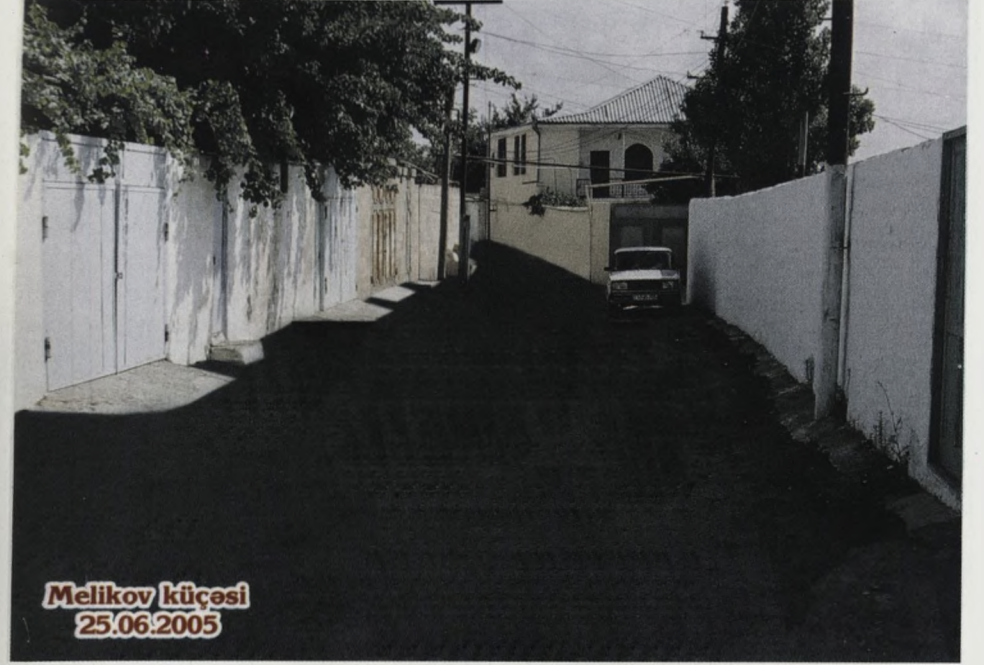
M.Ə.Rəsulzadə bələdiyyəsinin ərazidə apardığı təmir-tikinti işlərindən bəzi məqamlar
