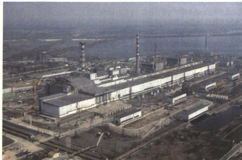
Şəkil 15.1. Çernobl Atom Elektrik Stansiyası qəzadan əvvəl
