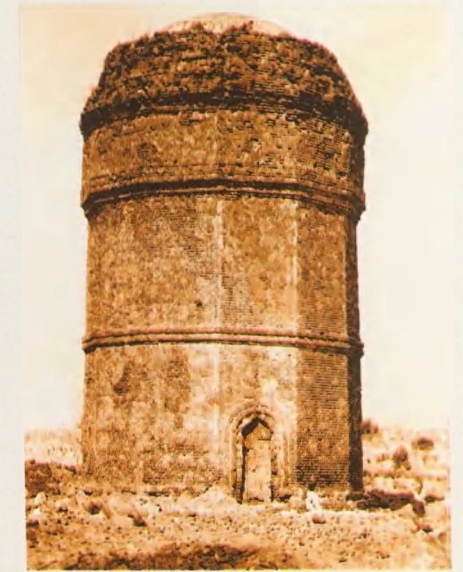
Cəfərabad // Pir Hüseyin türbəsi gümbəzi dağılmış halda
