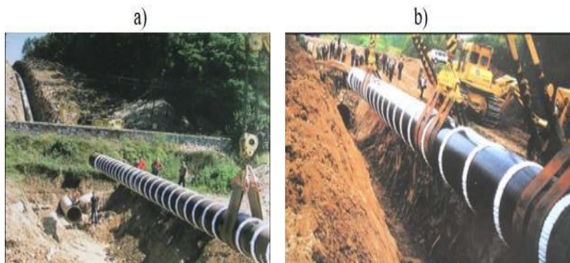
Şək. 9.1. Boru kəmərinin dəmir və avtomobil yollarından yeraltı keçidinin tikilməsi
