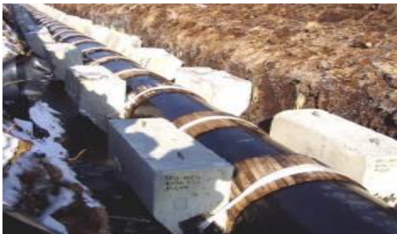
Şək. 2.3. Boru kəmərinin beton ağırlaşdırıcılarla ballastlaşdırılması
