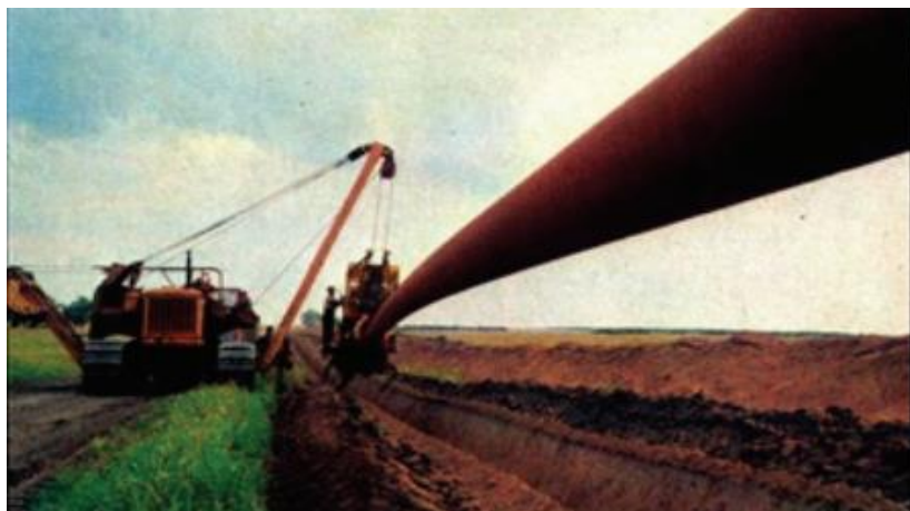
Şək. 8.6. Boru kəmərinin xəndəyə düzülməsi
