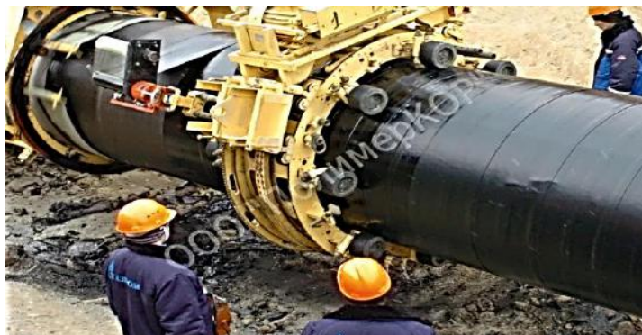
Şək. 8.2. Boru kəmərlərinin polimer lentlə izolyasiya edilməsi
