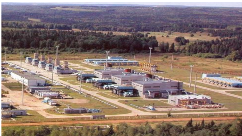
Şək. 1.12. Magistral qaz kəmərinin kompressor stansiyası
