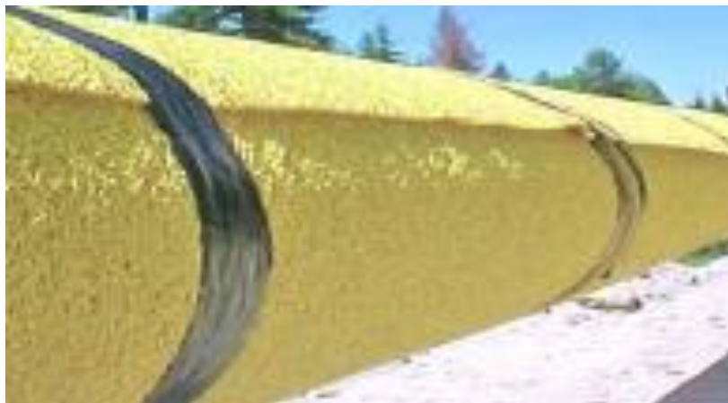
Şək. 2.4. Boru kəmərinin izolyasiyasını mühafizə edən futerovka qatı
