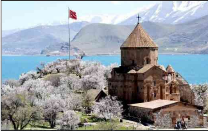
Ağtomar adasındakı Müqəddəs Xaç kilsəsi təmirdən sonra
