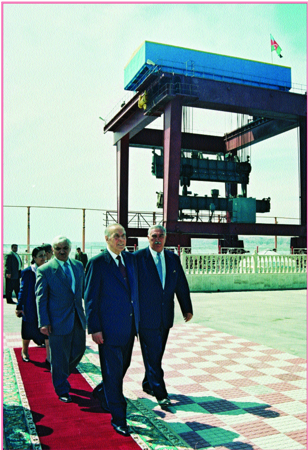
Şamkir, Su-elektrik stansiyası
