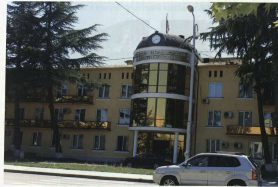
Marneuli rayonu sakrebulosunun (şurasının) və rayon icra hakimiyyətinin binası
