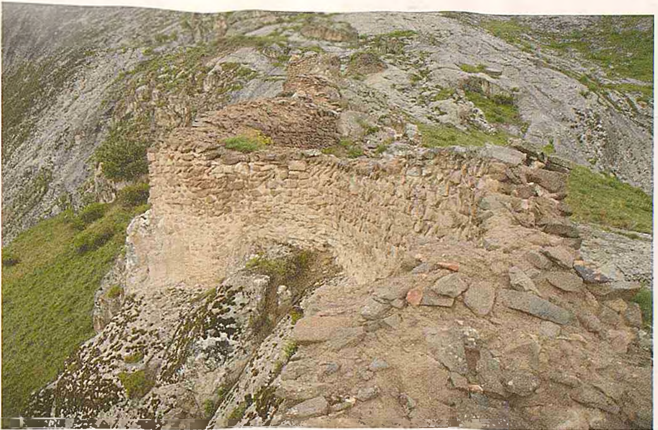
Şəkil 11. Şimal divarın tikinti texnikası. Рисунок 11. Техника кладки северной стены. Picture 11. Laying technique of the northern wall.
