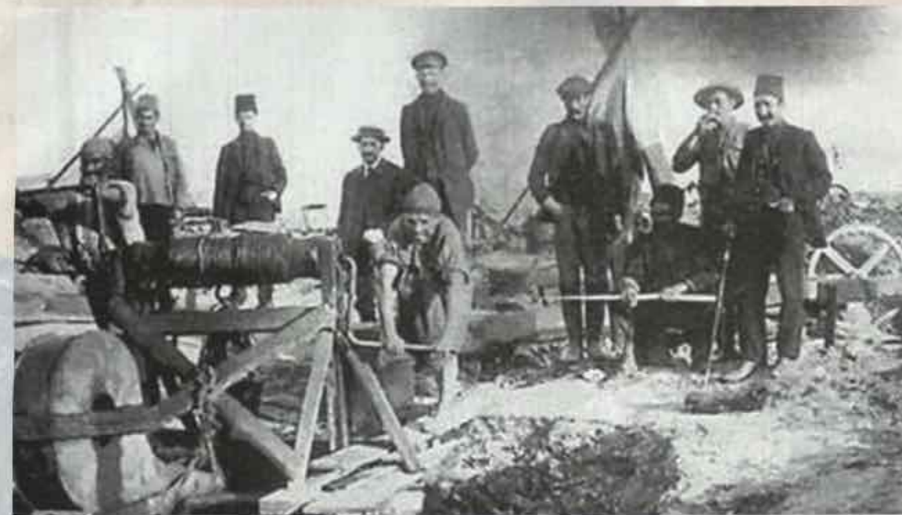
XIX əsrdə Bibiheybat yatağında neftin al çarxı vasitəsi ilə quyudan qaldırılması
