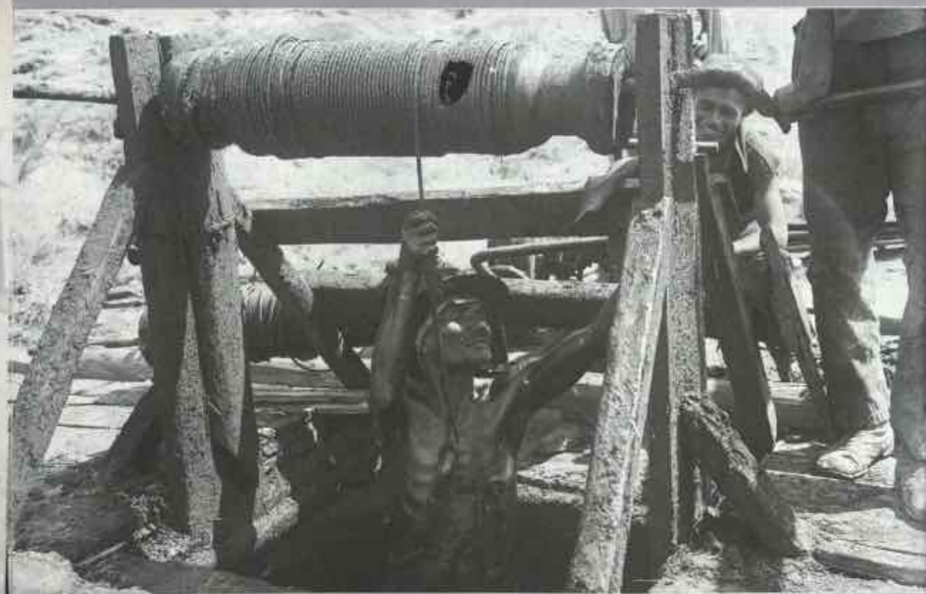
Bakıda neftin quyusu üsulu ilə çıxarılması
