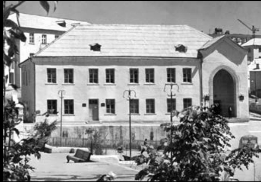
Mehmanxana binası. Daşkəsən şəhəri, 1970-ci illər
