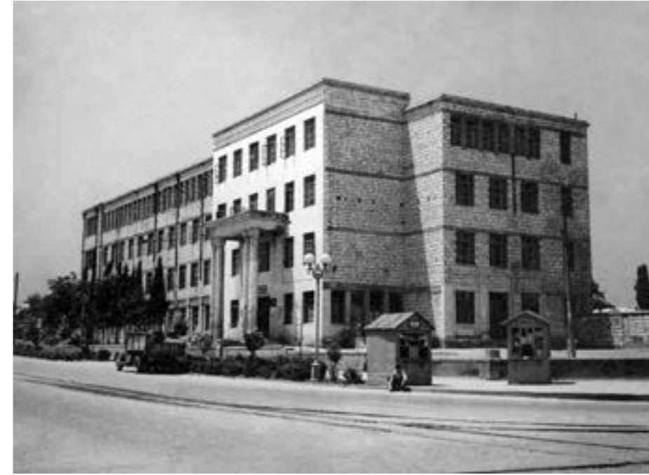
Orta məktəb binası. Kirovabad (indi Gəncə) şəhəri, 1950-ci illər Building of school, city of Kirovabad (nowadays city of Ganja), 1950 th years
