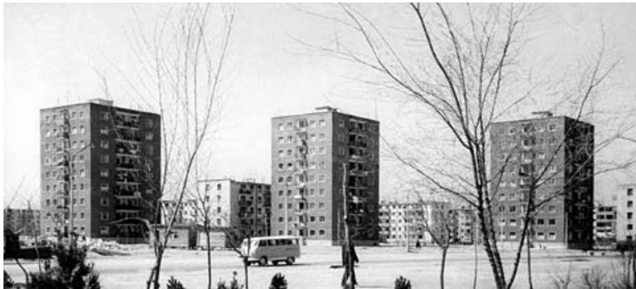
4-cü mikrorayonun tikintisi. Sumqayıt şəhəri, 1970-ci illər City of Sumqayıt. Building of the residential district No. 4, the 1970 th years
