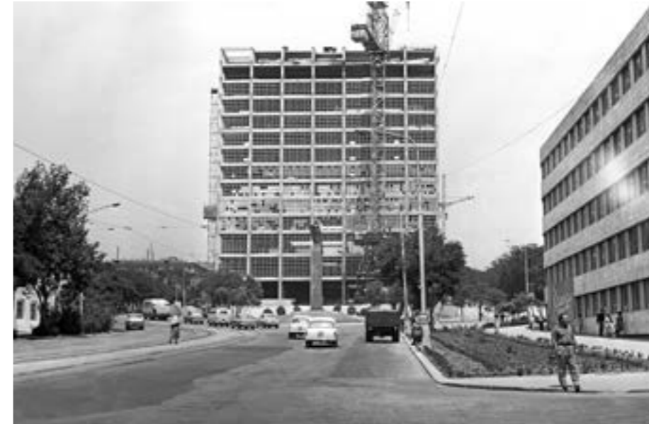
“Textikintitəşkilatı” trestinin inzibati binasının tikilməsi. Müəllif: memar Şəfiqə Zeynalova, 1970-ci illər During construction of the building of trust “Tekhtikintitəşkilatı”. Architect Şafiqə Mikayil Zeynalova, the 1970 th years
