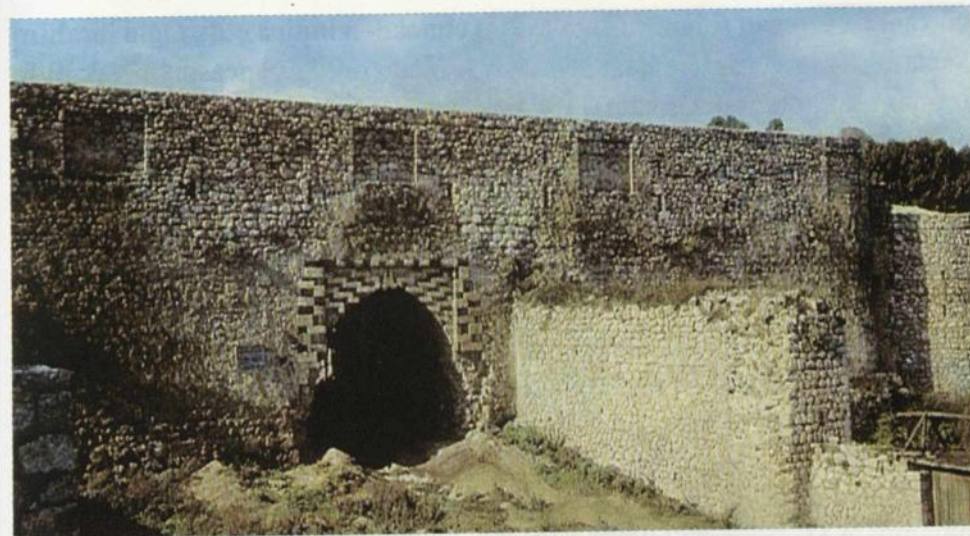
Gəncə şəhərinin qədim qala hasarları və qapısı
