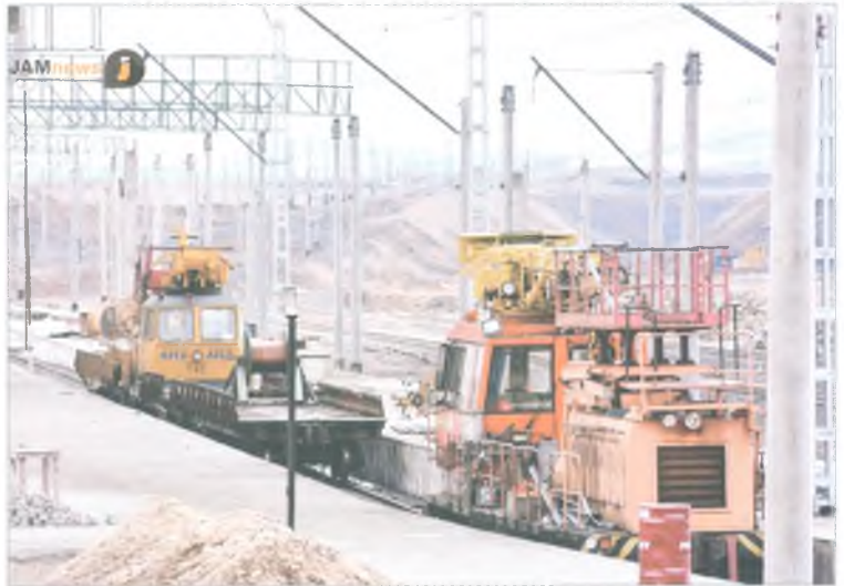
Bakı – Böyük Kasik dəmir yolunun elektrik təchizatının yenidən qurulması
