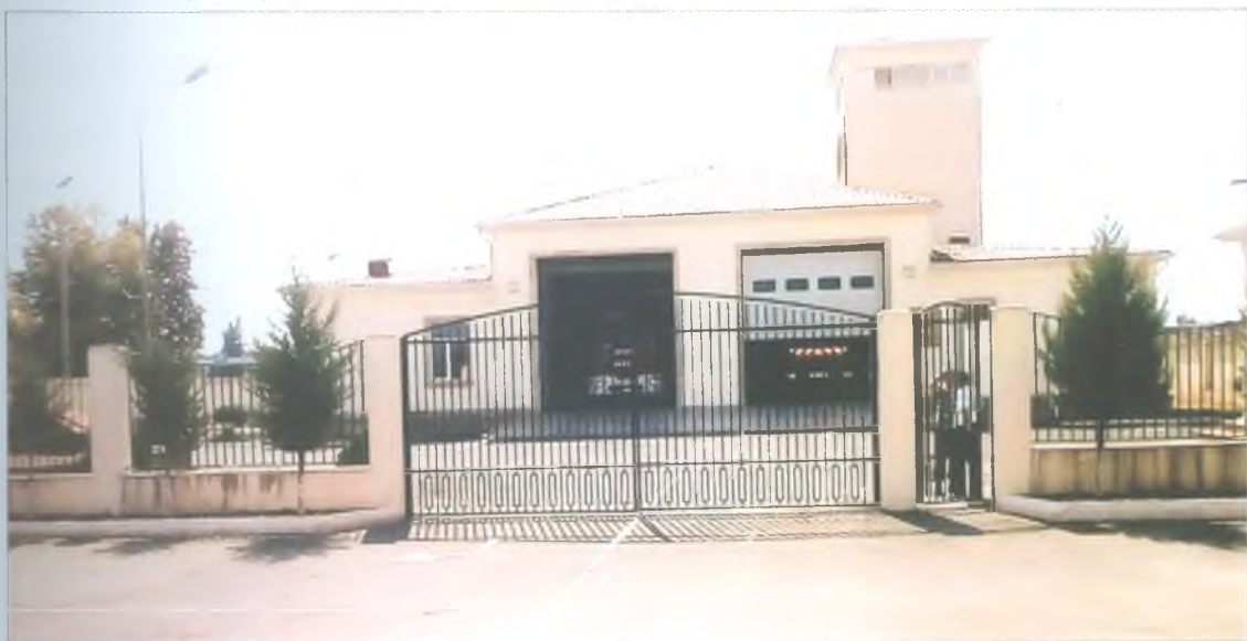
Lənkəran rayonu Liman şəhərində yanğınsöndürmə deposu
