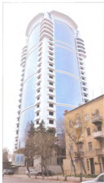
S. Vurgun küçəsi 79 ünvanında inşa edilən 25 mərtəbəli yaşayış binası
