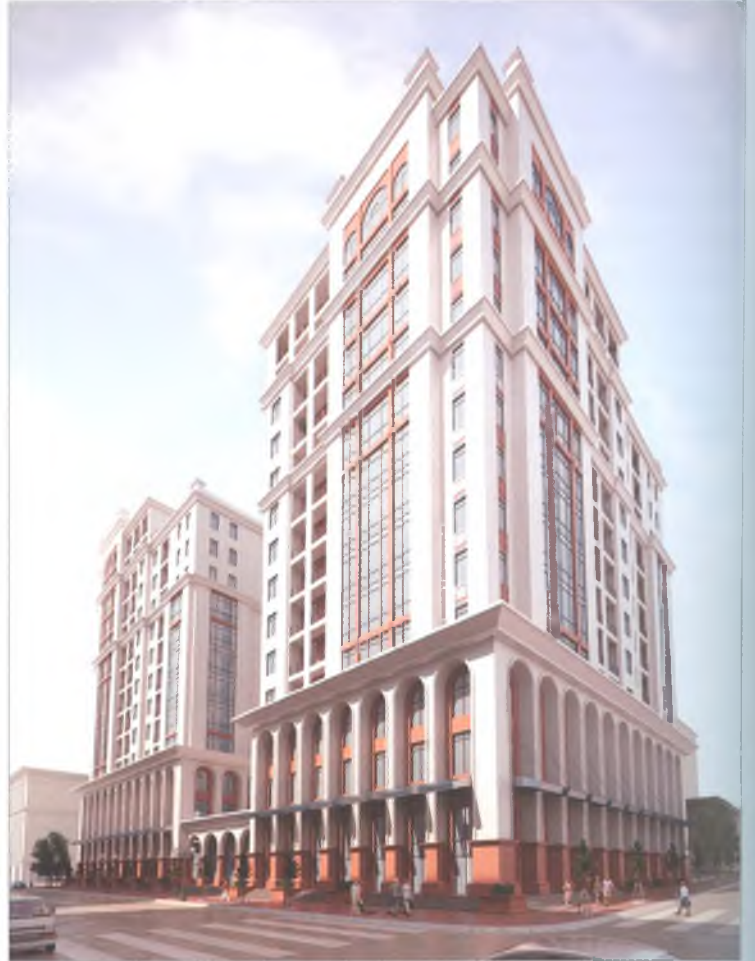
Bakı şəhəri, Neftçi Qurban küçəsində yerləşən çoxmərtəbəli yaşayış binası
