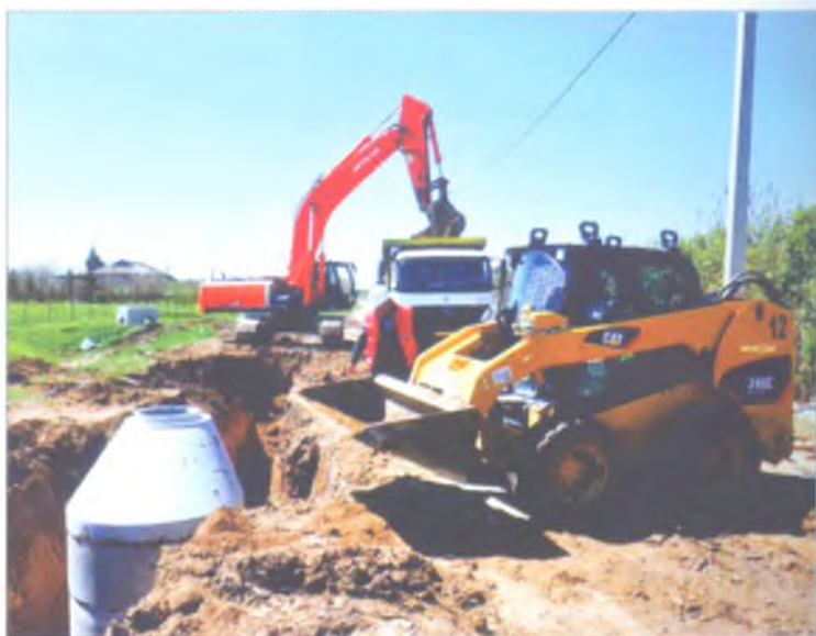
“Cəlilabad şəhərinin Su Təchizatı və Kanalizasiya Sistemlərinin Yenidən Qurulması” layihəsi obyektinin tikintisindən bir görüntü
