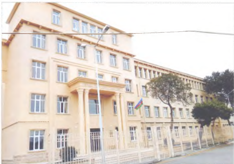
Maştağa qəsəbəsində orta məktəb binası
