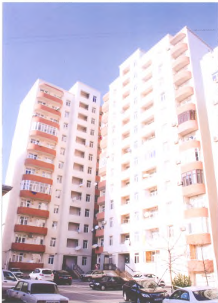
Badamdar qəsəbəsində 12 mərtəbəli 2 girişli monolit konstruksiyalı yaşayış kompleksi
