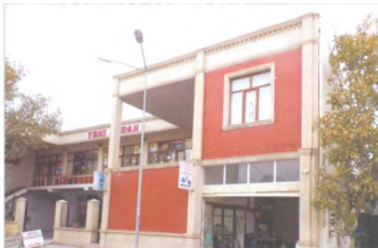
Gəncə şəhəri, Kəpəz rayonu, Vəli Xuluflu küçəsində "Yeni Məkan" xidmət obyektii
