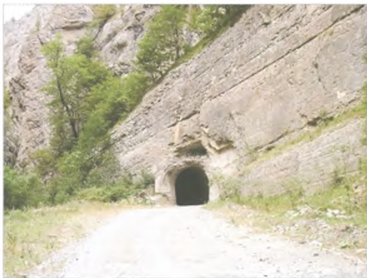
Kəlbəcər-Laçın yolundakı tunel
