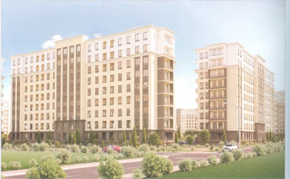
Qaradağ rayonu, Qobu qəsəbəsi ərazisində, məcburi köçkünlər üçün yaşayış binaları
