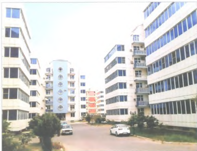
Lənkəran şəhərində 7 mərtəbəli yaşayış kompleksi
