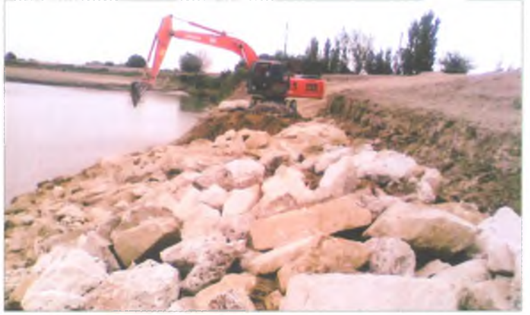
Kür çayı sahilində bəndatma işləri
