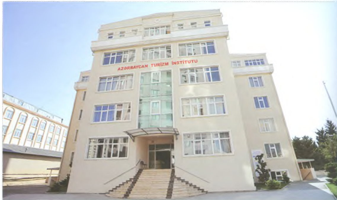
Bakı şəhəri, Nərimanov rayonu, K. Rəhimov küçəsi, 822-823-cü məhəllədə Azərbaycan Turizm İnstitutunun binası
