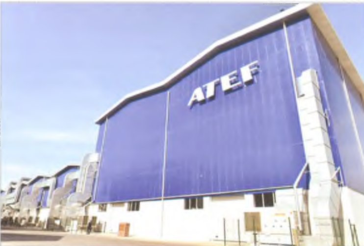
ATEF Şirkətlər Qrupunun Suraxanı rayonu ərazisində yerləşən transformator zavodu
