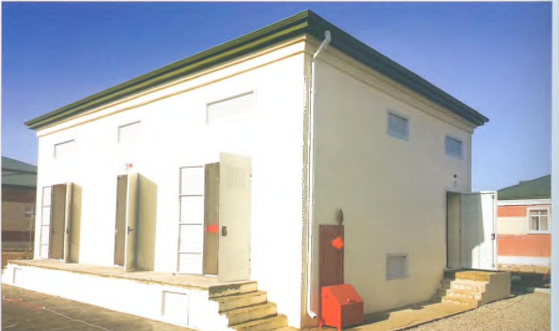
Tikintinin 2-ci mərhələsində quraşdırılan qapalı yarımstansiya məntəqəsi
