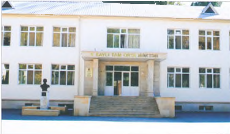
Mingəçevir şəhərində 9 saylı orta məktəb binası
