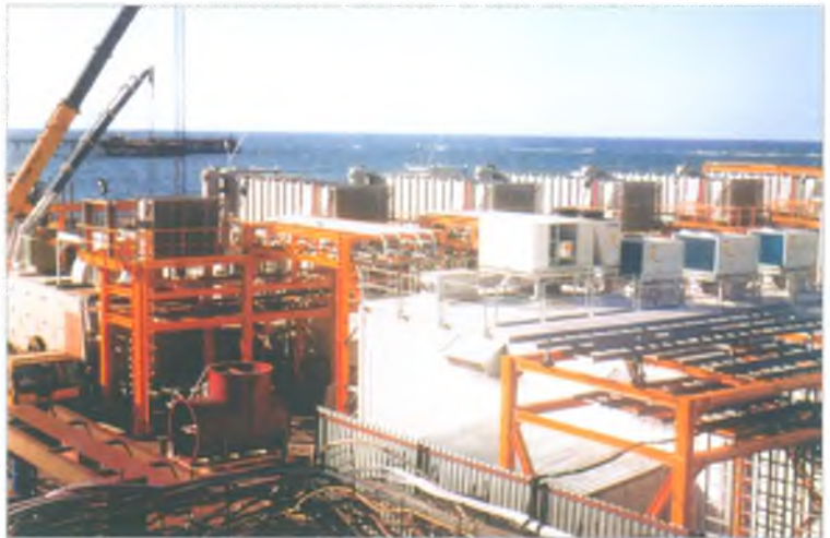
Neft Daşlarında yeni Qaz Turbin elektrik stansiyasının tikintisi
