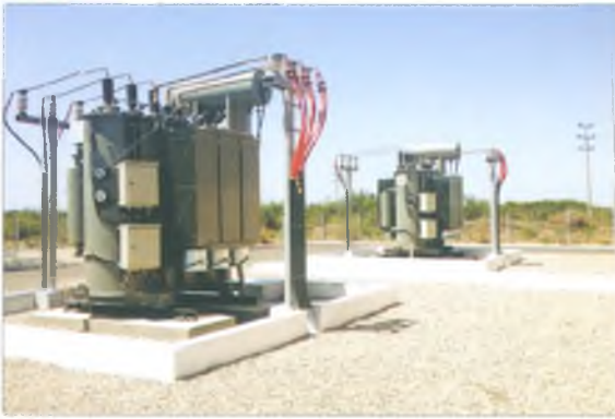
Yeni 35/10 kV-luq yarımstansiyanın tikintisi
