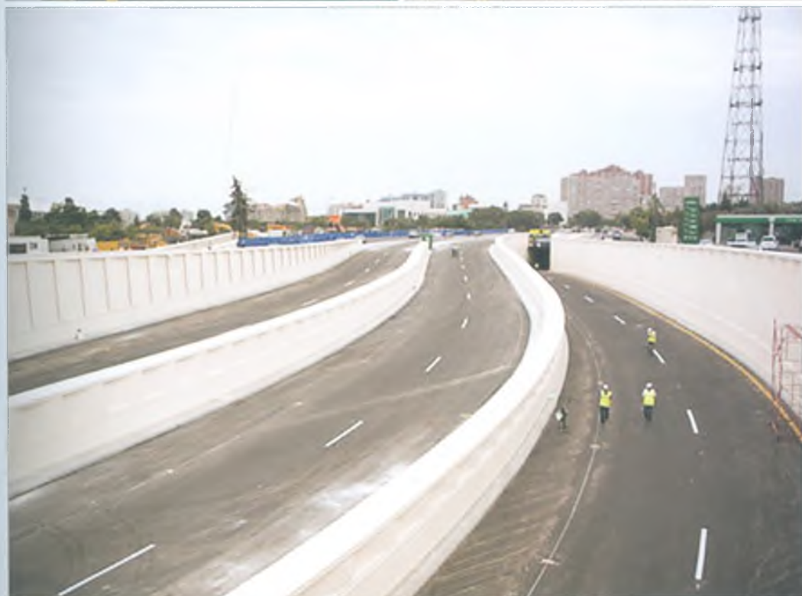
Bakıda "Qələbə meydanı" müxtəlif səviyyəli tunel tipli yol qovşağı layihəsi çərçivəsində inşa edilən tuneldən görüntülər...
