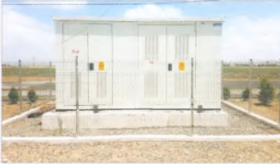
Tikintinin 1-ci mərhələsində quraşdırılan 1000 kVA gücündə komplekt transformator məntəqəsi
