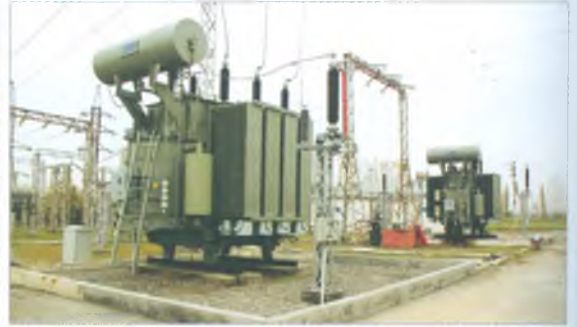
Xındırstan qəsəbəsində 110/35/10 kV-luq yarımstansiyanın yenidənqurulması
