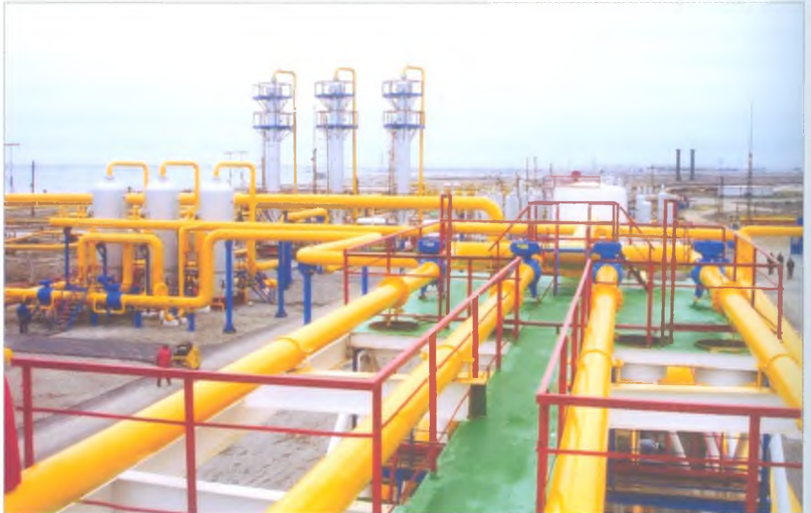
Hövsan qəsəbəsində Qaz yığımı və separasiya qurğusunun tikintisi
