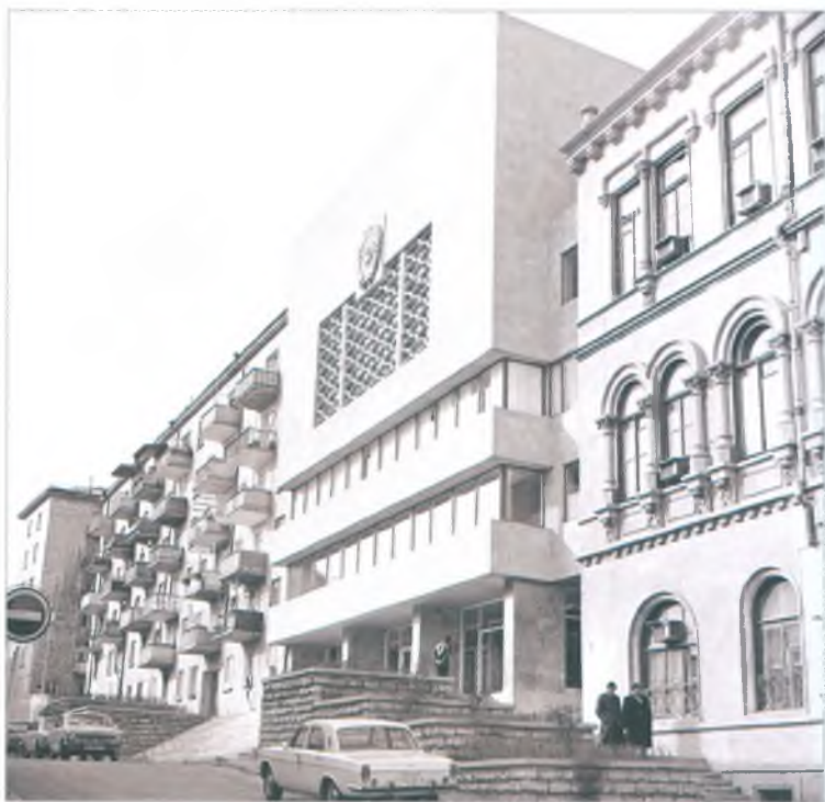
Bakı şəhəri, Azərbaycan SSR Prokurorluğunun xidməti binası. 1977-ci il. Memarlar A.Surkin, Q. Sadiqov
