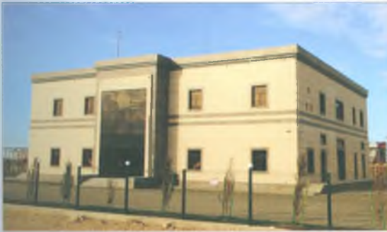
110/35/10 kV-luq 2x80 mVA gücündə GIS sistemli qapalı yarımstansiya
