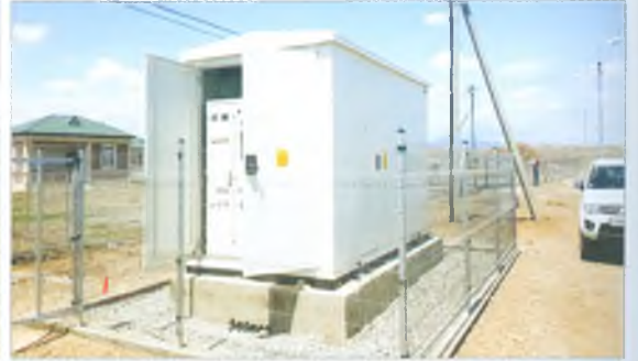
Tikintinin 1-ci mərhələsində quraşdırılan 1000 kVA gücündə komplekt transformator məntəqəsi
