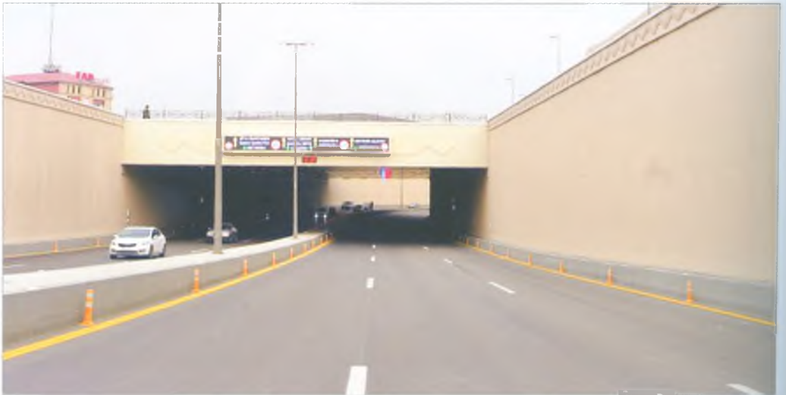
Ziya Bünyadov prospektində avtomobil tuneli
