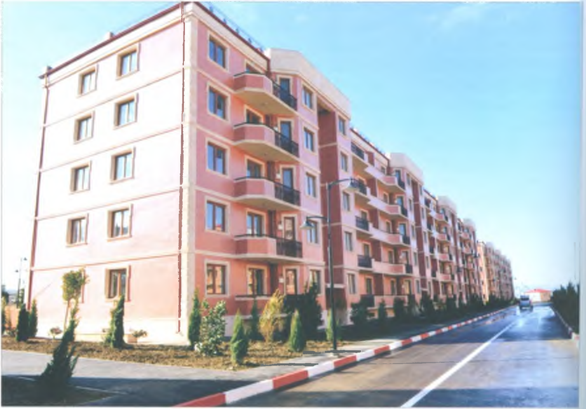
Bakı şəhəri, Qaradağ rayonunun Müşfiqabad qəsəbəsində 5 mərtəbəli yaşayış binası
