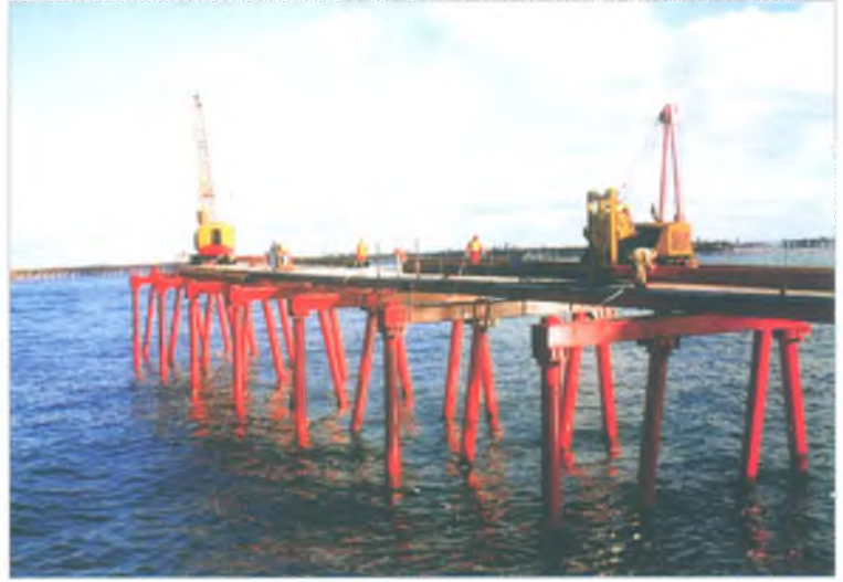
Neft Daşlarında yeni estakadanın tikintisi
