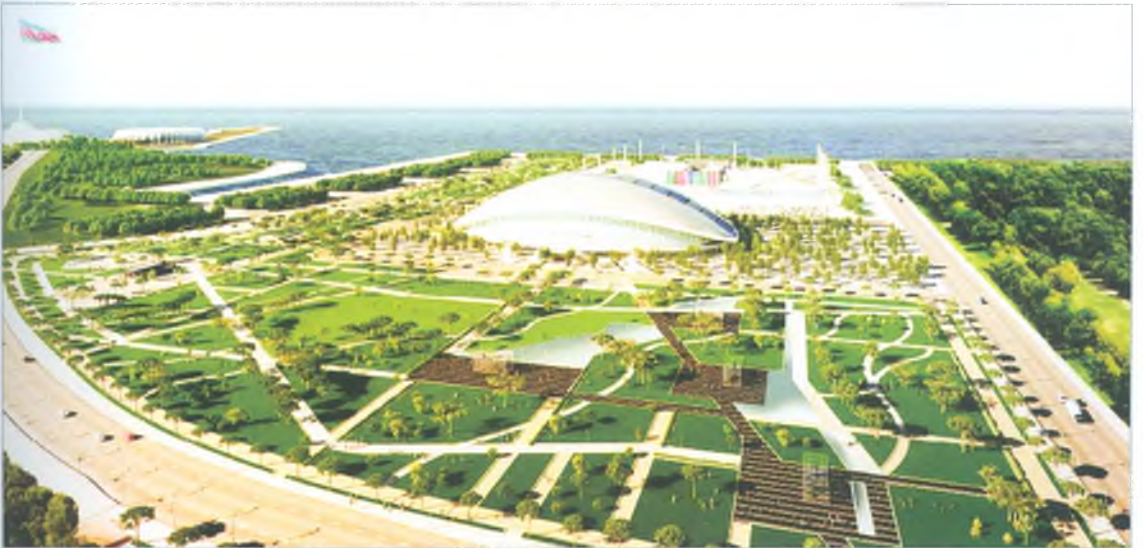
Su İdman Sarayının avtodayanacaq hissəsinin inşası
