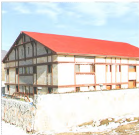
110/10-10 kV-luq qapalı “Şahdağ” yarımstansiyası
