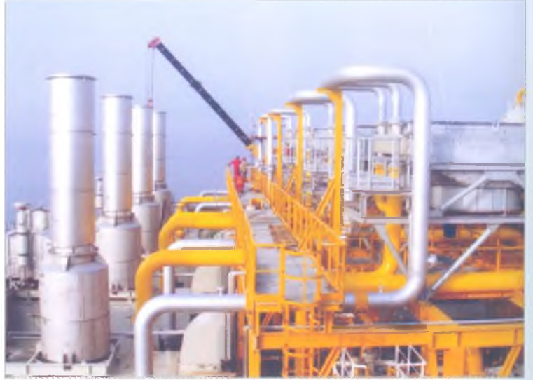
Neft Daşlarında 2 saylı sıxıcı kompressor stansiyasının genişləndirilməsi
