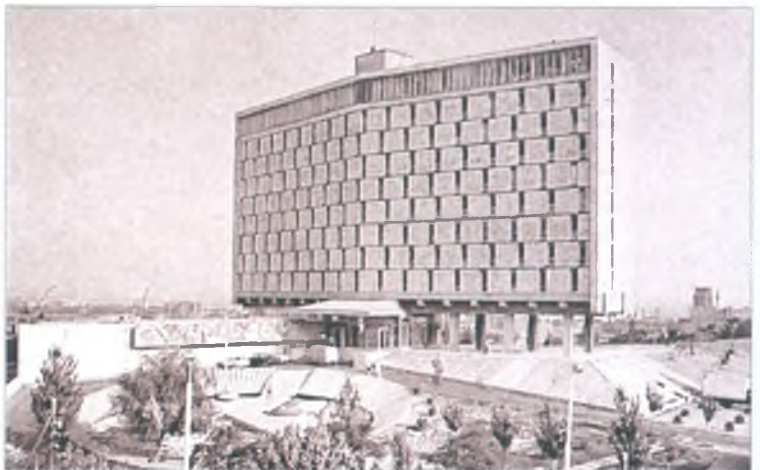
Bakı şəhəri, "Turist" (sonrakı adı "Qarabağ") mehmanxanasının binası. Memar V.Şulqin, 1974-cü il (indi sökülüb)
