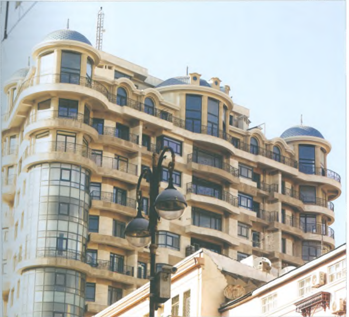
Bünyad Sərdarov küçəsi 14 ünvanında “Caspian Service” MMC inşaatçılarının əməyi ilə ucalan bu çoxmərtəbəli bina əsil memarlıq abidəsidir
