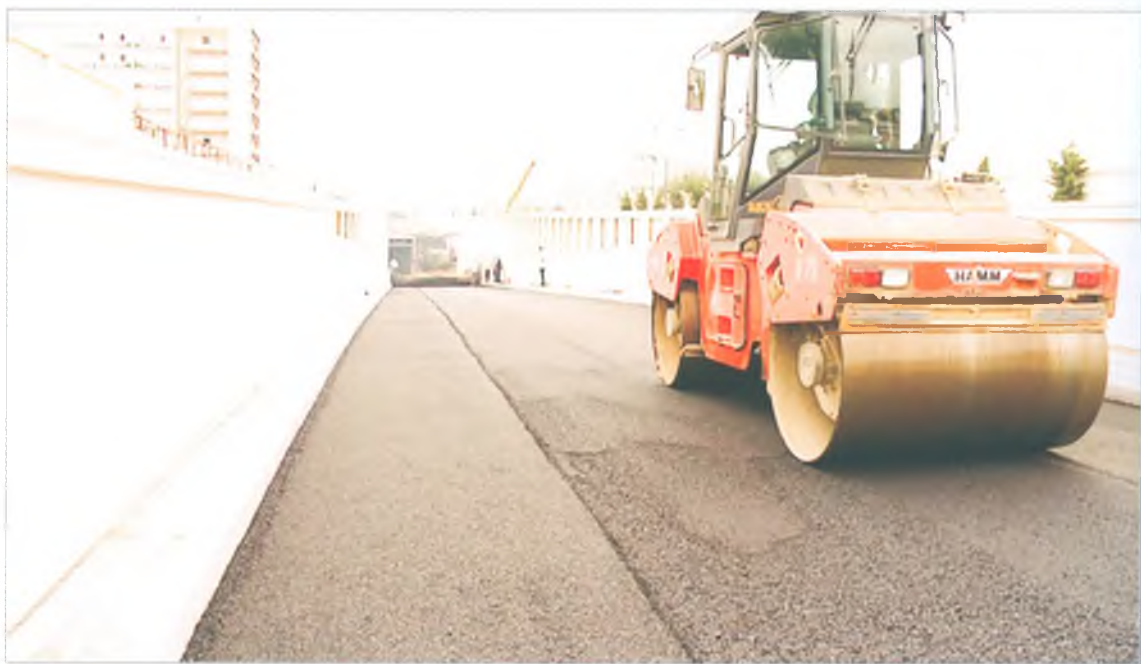
"Gənclik" metro stansiyasının yaxınlığında yerləşən "Qələbə" meydanında tunnel kompleksinin tikintisindən görüntü..
