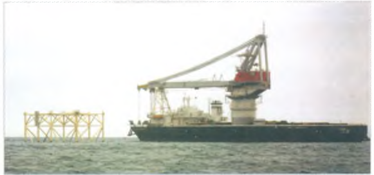
“Qurban Abasov” kran gəmisi ilə yeni quraşdırılmış dayaq platforması
