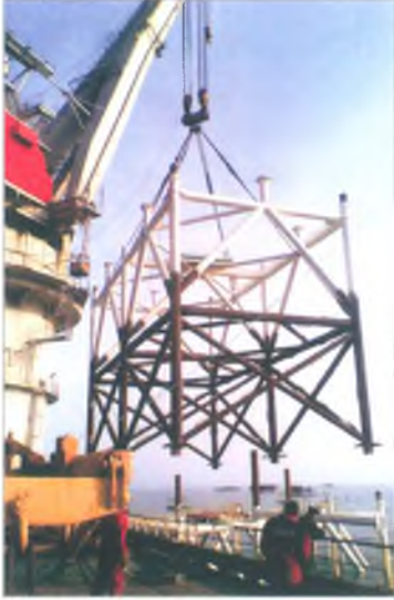
Neft Daşlarında yeni platformanın tikintisi
