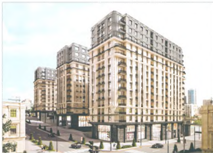
Bakı şəhəri, Nəsimi rayonu, Ş.Əzizbəyov, S.Vurğun, Mərdanov qardaşları və S.Əsgərova küçələrinin əhatə etdiyi ərazidə yüksəkmərtəbəli yaşayış binaları.
