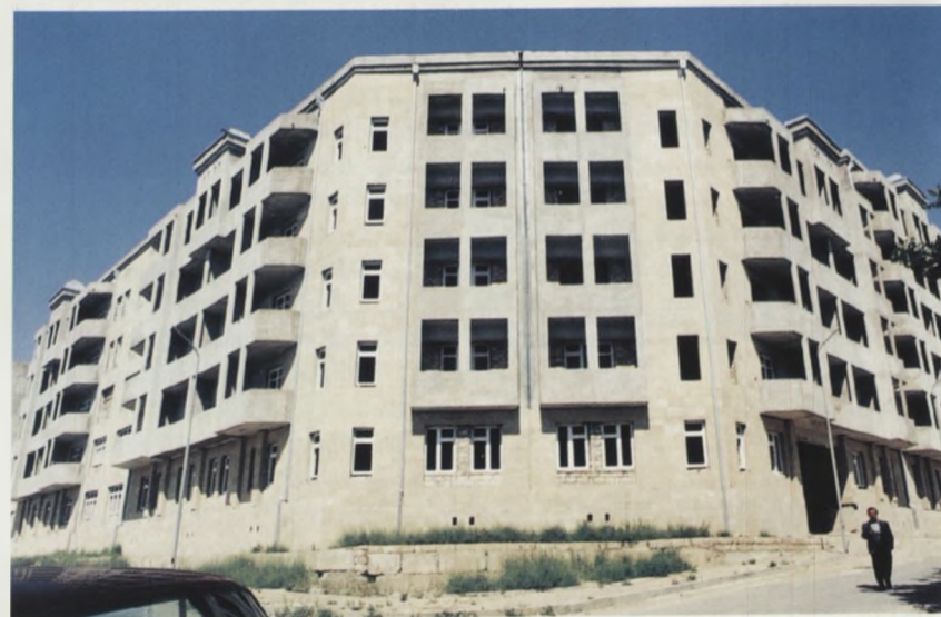
Milli Məclisin yaşayış binası * Dwelling House of the Milli Mejlis
