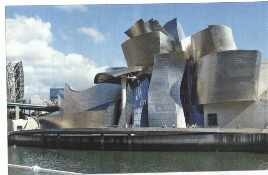
Dekonstruktivizm. Quggenheym muzeyi. Bilbao (İspaniya). Memar F.Geri.
