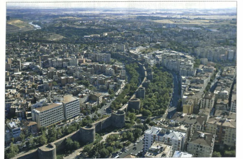
Diyarbəkir şəhərindən görünüş.
