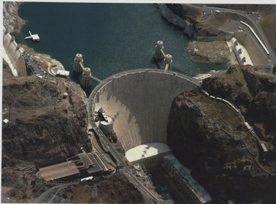
Kolorado çayı üzərində tağvarı, qravitasiya bəndi ("Huver bəndi", hünd. – 221 m). ABŞ.
