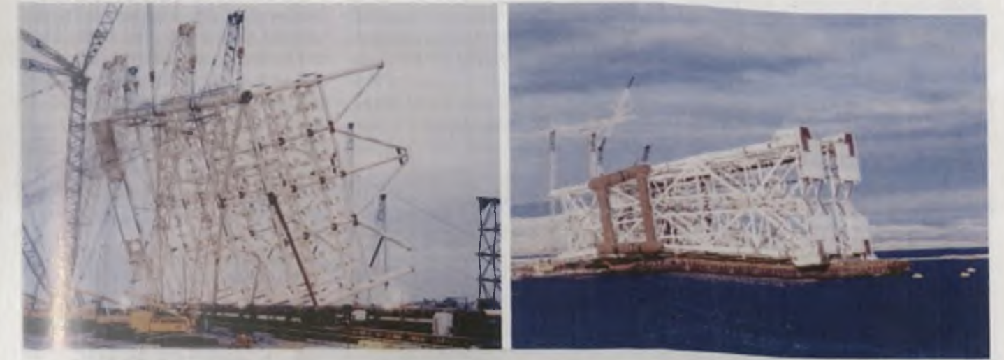
“Azəri” yatağının mərkəzi hissəsində quraşdırılmış özlülün dayaqlı blokları.
