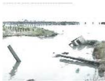
Keşlə kollektorunun dənizə çıxışı
