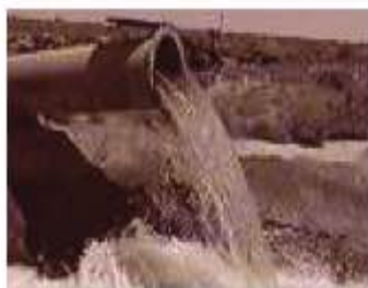
Qaraçala-Kürsəngi kollektorunun Baş Şirvan kanalına qoşulması
