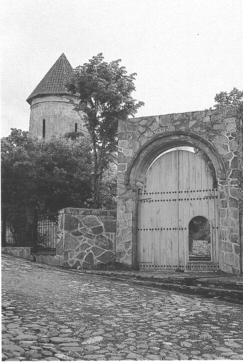
Kiş alban məbədinin təmir-bərpadan sonrakı görünüşü
